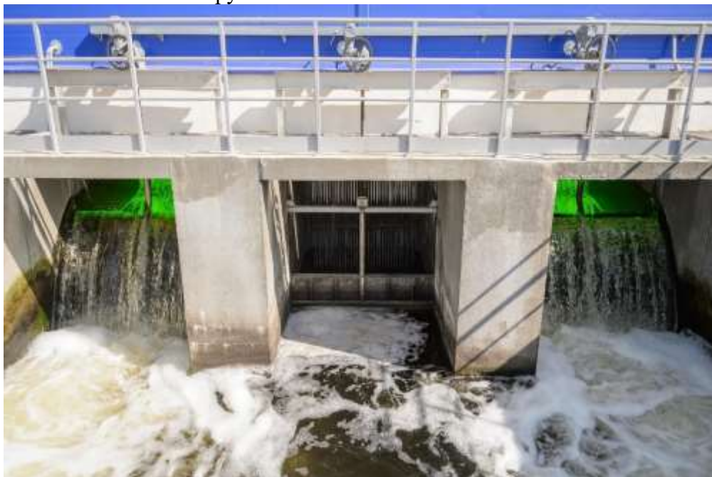
Рисунок 2 - гидроузел №2 на реке Липка в селе Николо-Урюпино (ГТС №2) городского округа Красногорск Московской области
